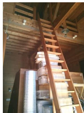
写真8 ロフトへと続く階段
